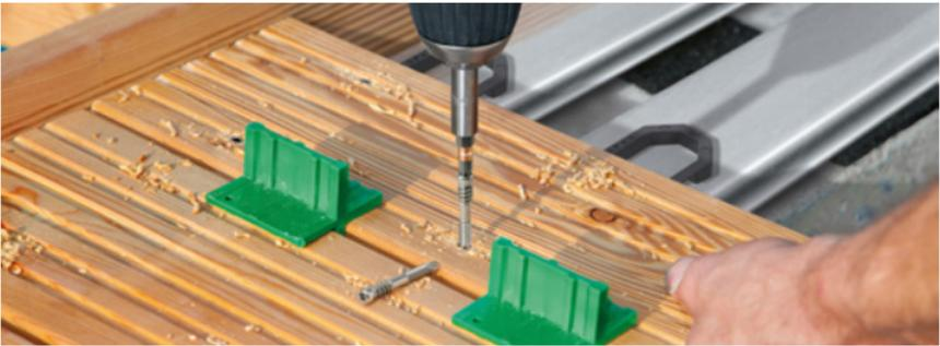
Das Fixiergewinde verringert Knarrgeräusche in der Dielenkonstruktion. Stabiles Blech-Doppelgang-Gewinde für erhöhte Haltekräfte in Aluminium. Bohrspitze für Aluminiumprofile bis 4,0 mm Wandstärke ohne Vorbohren des Aluminiums. Sehr niedrige Aufbauhöhe der Terrassengesamtkonstruktion von min. 46 mm möglich.
